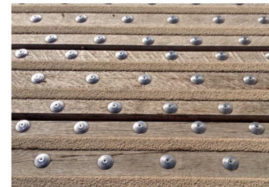
**Podo'plat®** : plots en inox vissés dans les lames de platelage pour réaliser une bande d'éveil à la vigilance pour les personnes mal voyantes. Mise en place devant les escaliers, ruptures de niveau ou tout autre obstacle pouvant présenter un danger.
