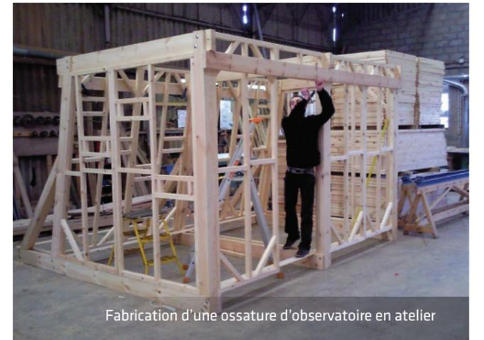
Fabrication d'une ossature d'observatoire en atelier
