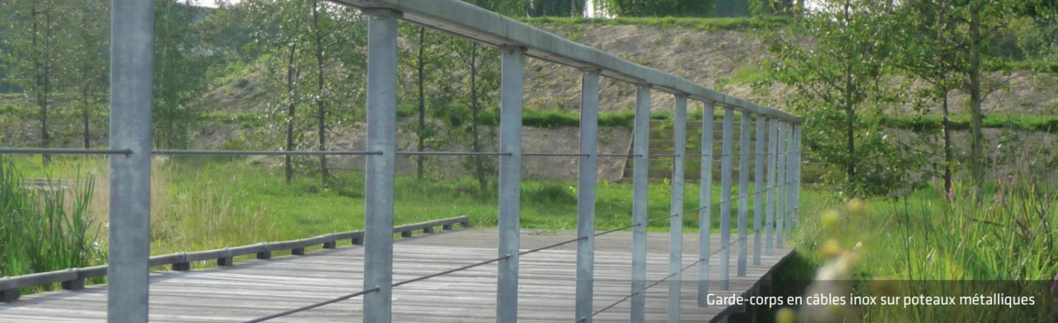
Garde-corps en câbles inox sur poteaux métalliques
