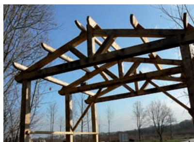
Ossatures avec assemblage tenons/mortaises
