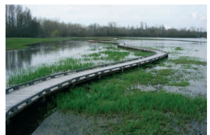
Cheminement avec chasse-roue - zone d'expansion crue - Structure en chêne et platelage brut non raboté en robinier faux acacia
