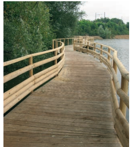
Cheminement en pied de berge - structure et platelage en chêne et garde-corps en châtaignier
