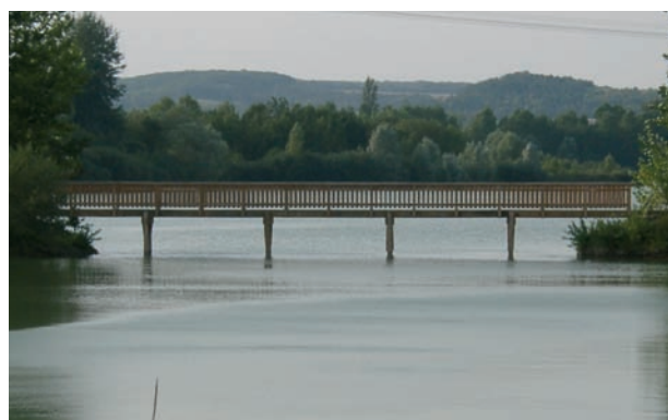
Passerelle droite sur portiques bois, poutres brutes / Platelage non raboté en robinier faux acacia Garde-corps normalisé en chêne, à balustres verticales
