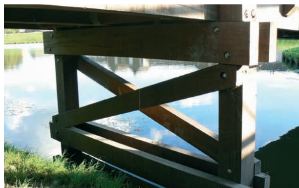
Passerelle droite sur portiques bois, poutres brutes / Platelage non raboté en robinier faux acacia Garde-corps normalisé en chêne, à balustres verticales
