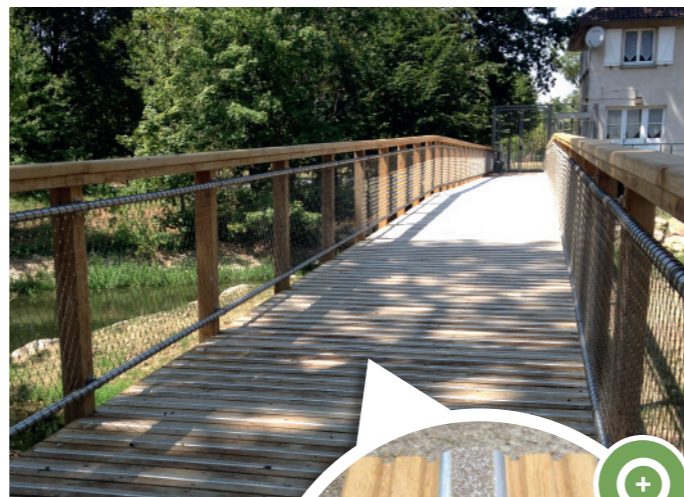
Barrettes antidérapantes RugoPlat® Profilé aluminium anodisé avec résine époxy chargée en corindon
