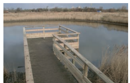
Ponton avec plateforme
