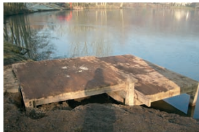
Ponton à deux niveaux
