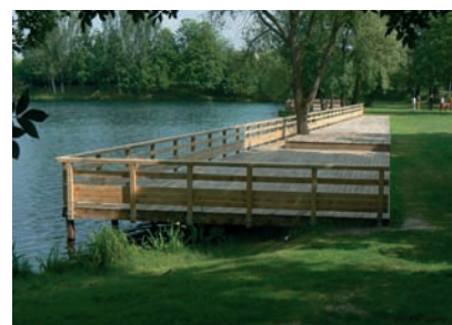
Deck en bois naturellement durable avec intégration d'un arbre
